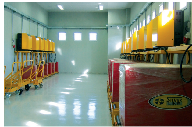
Construída em um anexo do CD, a sala de baterias da Cyber Logística tem ventilação forçada
