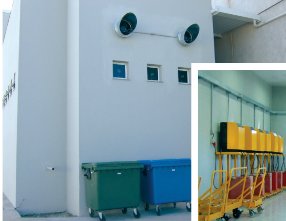
Construída em um anexo do CD, a sala de baterias da Cyber Logística tem ventilação forçada
